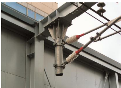
鋼管柱フランジ止め
