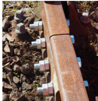
レール継目板ボルト (英国)
