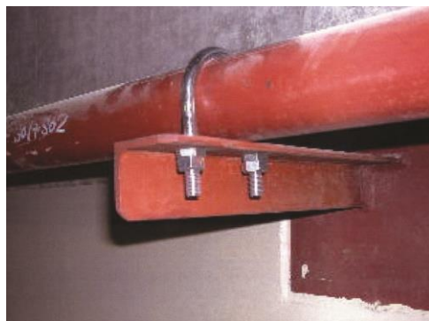
施設内配管止め
