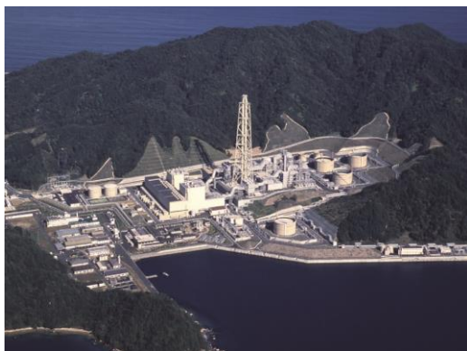
原子力発電所
